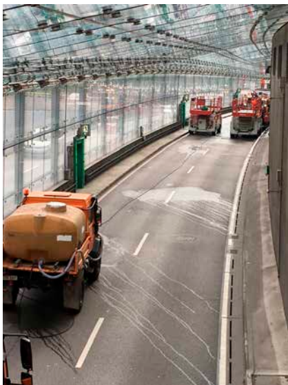
Abb. 3: Blick in die abgesperrte Glaseinhausung während der Reinigungsarbeiten
