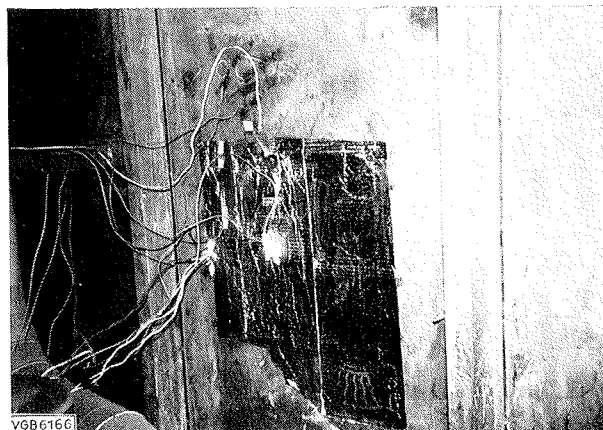
Abb. 13. Temperatur- und Wärmeverlustmessung mit überklebter Aluminiumfolie.
