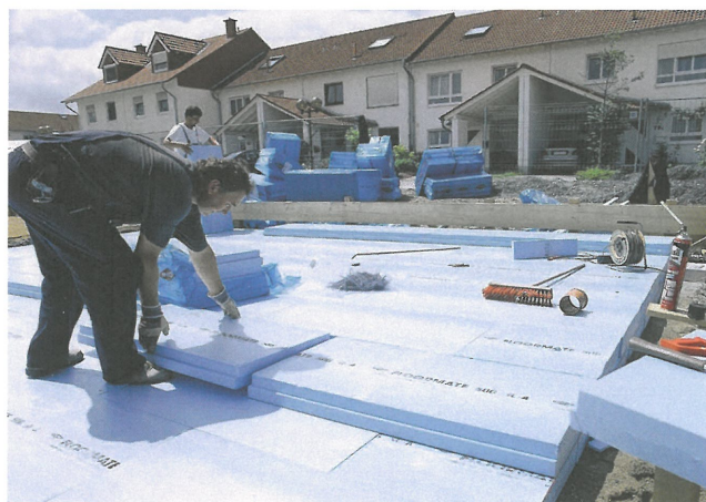
Bild 18. Dreilagige Verlegung von XPS-Platten unter der lastabtragenden Gründungsplatte eines Wohngebäudes (Foto: DOW Deutschland)
