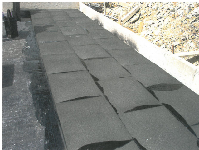
Bild 14. Verlegung von Schaumglasplatten unter der Gründungsplatte mit Bitumen als Kleber und zwischen den Platten (Foto: Deutsche FOAMGLAS GmbH)
