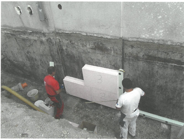
Bild 8. Anbringung von EPS als Perimeterdämmung (Foto: FIW München)
