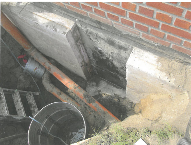
Bild 17. Ausbau einer XPS-Perimeterdämmung aus der Kellerwand eines Privatgebäudes in Bocholt im drückenden Wasser mit Grundwasserabsenkung um ca. 1 m (Foto: FIW München)
