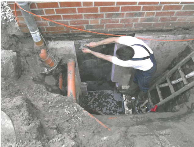
Bild 16. Ausbau einer XPS-Perimeter-Dämmplatte der Wanddämmung im drückenden Wasser eines Seniorenheims in Bottrop mit Grundwasserabsenkung um ca. 1 m (Foto: FIW München)
