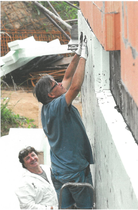
Bild 11. Wärmedämmung eines Sockels vor dem Anbringen des WDV-Systems (Foto: BASF SE)
