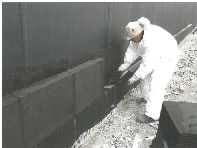
Bild 10. Vollflächige Verklebung von Schaumglas-Platten an der Kelleraußenwand für die Anwendung im drückenden Wasser (Foto: Deutsche FOAMGLAS GmbH)
