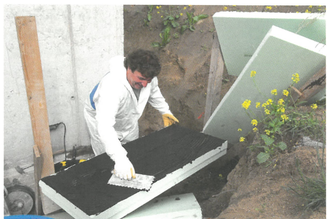
Bild 9. Vollflächiges Aufbringen des Klebers auf eine XPS-Platte (Foto: BASF SE)
