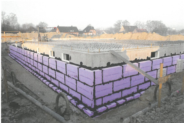
Bild 4. Perimeterdämmung mit abgedichteten Fugen und seitlichen Rändern (Foto: JACKON Insulation GmbH)
