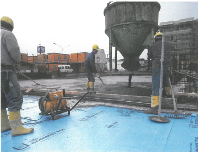
Bild 15. Betonieren der Gründungsplatte (Foto: DOW Deutschland)
